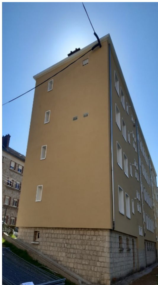
Bâtiment ITE fini avec des nidhoirs à moineau
